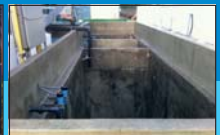
บ่อน้ำบาดาลเคลื่อน FRP และ EPOXY
