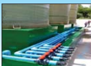
วางระบบท่อ PVC, PE, PP
