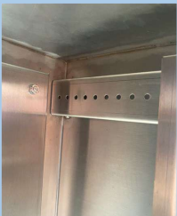
6 - ชั้นบันไดยึดสายไฟ
