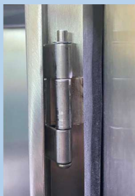
4 - บานพับกันน้ำ H-06-1 - ยางแบนพองน้ำ 3/4" x 3/16"
