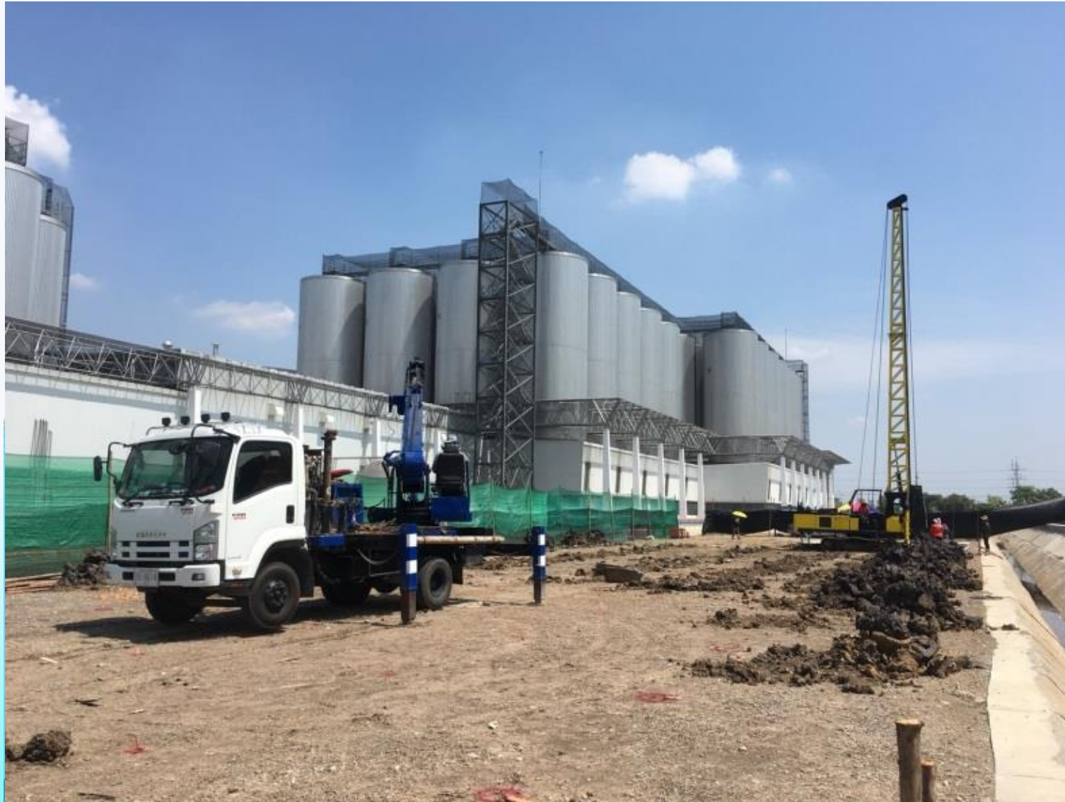
หน่วยงาน: บริษัท สิงห์ เบเวอเรจ จำกัด จ.นครปฐม เจาะน้ำเสาะเข็ม และตอกเสาเข็ม
