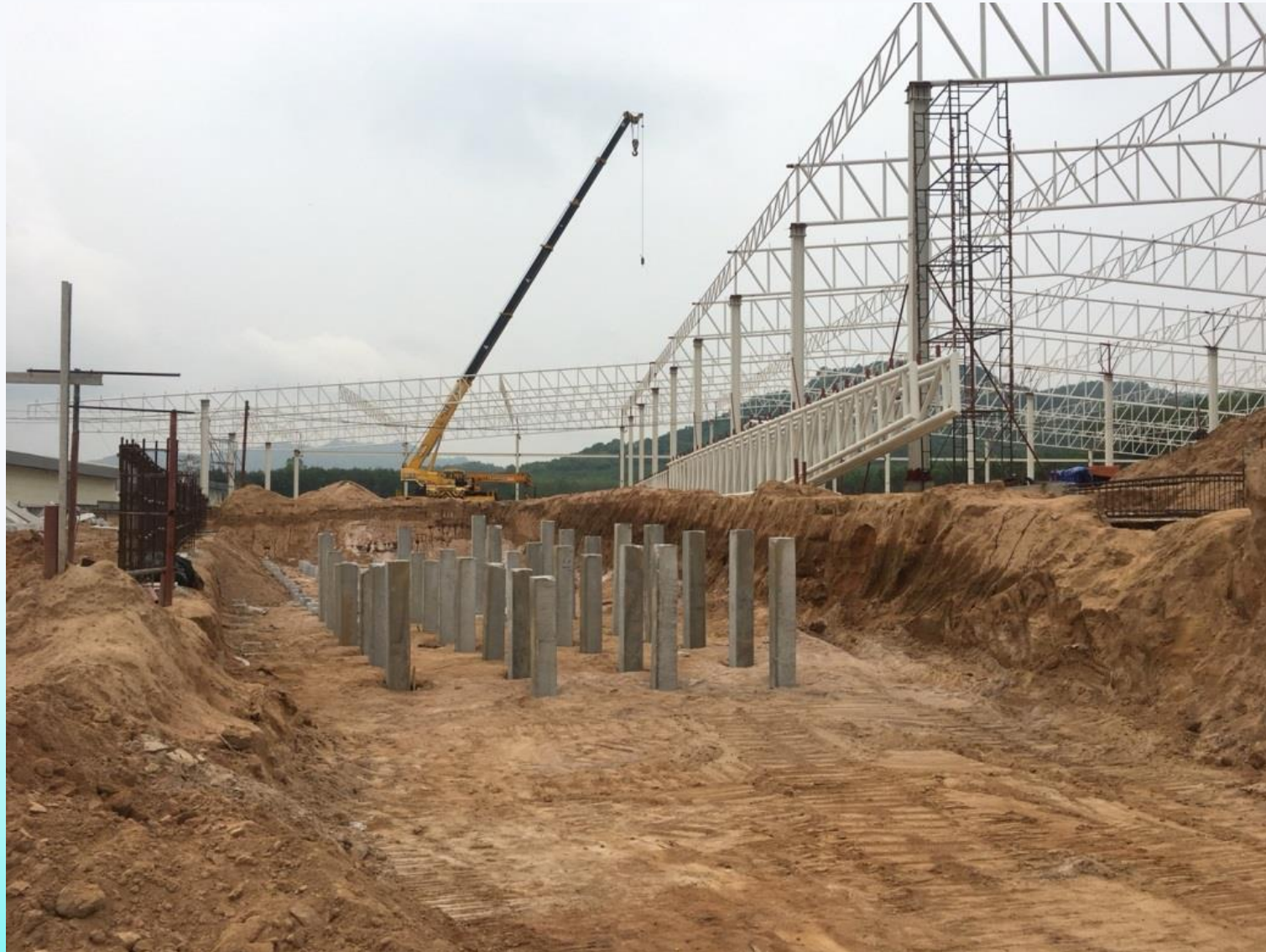
หน่วยงาน : บริษัท กรีนบอร์น88 จำกัด ตอกเสาเข็ม โรงงาน
