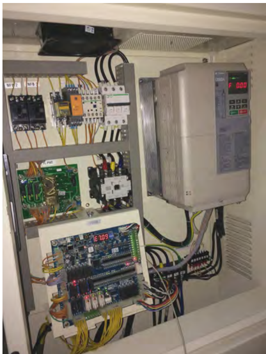
รูป ตู้ควบคุมรุ่นใหม่รับประกัน 3 ปี รูปจากงานลิฟท์ ที่ โรงแรม แพร่นครา
