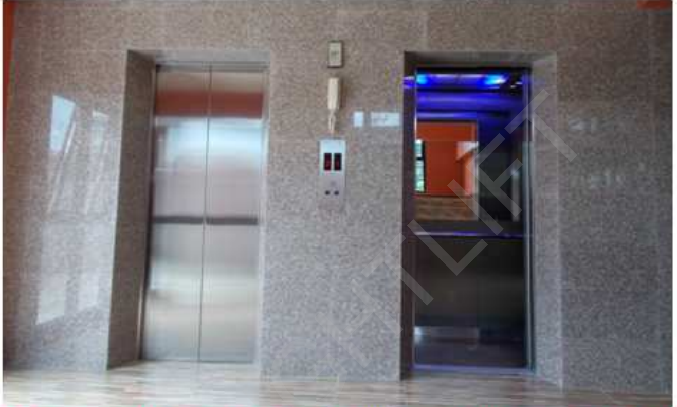
DOOR PANEL แบบ CENTER OPENING บานประตูและวงกบ STAINLESS เกรด 304
