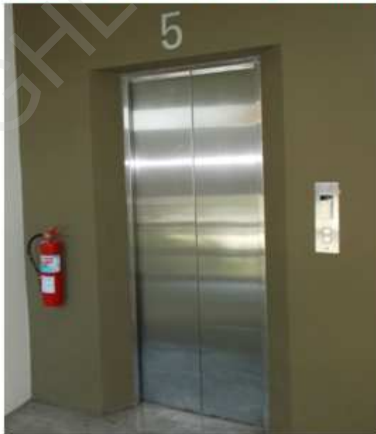
DOOR PANEL แบบ CENTER OPENING บานประตูและวงกบ STAINLESS เกรด 304
