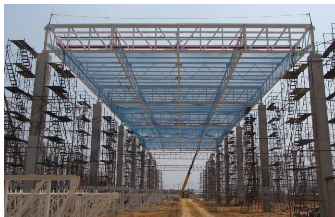
Safety Net ที่ทำการติดตั้งเรียบร้อยแล้ว
