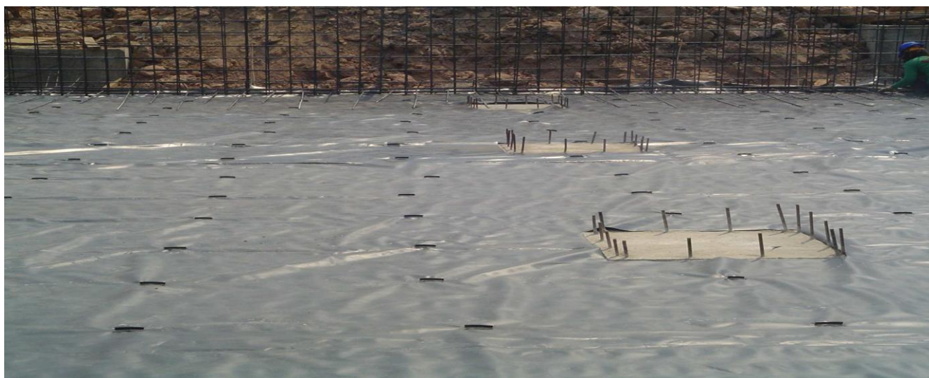
ภาพการปู LDPE รองพื้น ก่อนเทคอนกรีต
