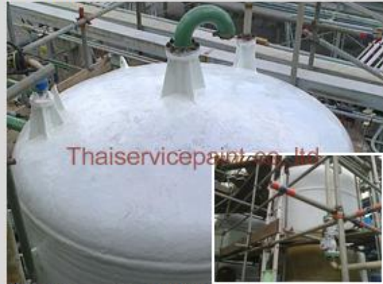
Thaiservicepaint co.,ltd. ชื่องาน :งานเคลือบ FRP พื้นที่ใช้งาน :แท้งค์เก็บสารเคมี Location :นิคมฯ มาบตาพุด
