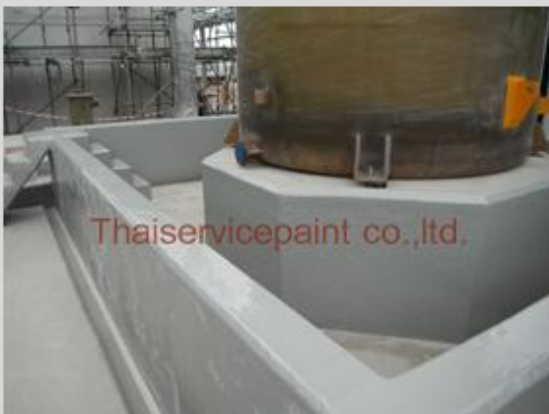
ชื่องาน : งานเคลือบ FRP พื้นที่ใช้งาน : เคลือบแท็งค์วางถังเก็บสารเคมี Location : นิคมฯ อีสเทิร์นซีบอร์ด
