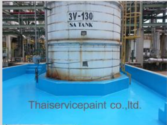
ชื่องาน : งานเคลือบ FRP พื้นที่ใช้งาน : เคลือบพื้นวางถังเก็บสารเคมี Location : นิคมฯ ผาแดง-ระยอง
