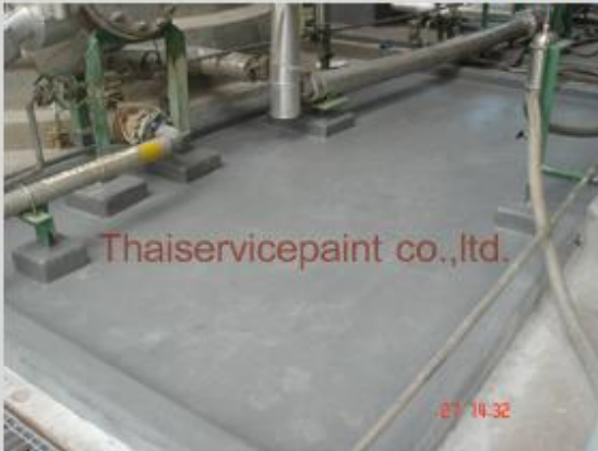
ชื่องาน :งานเคลือบ FRP พื้นที่ใช้งาน :พื้นที่สำหรับวางเครื่องจักร Location :นิคมฯ อมตะซีดี
