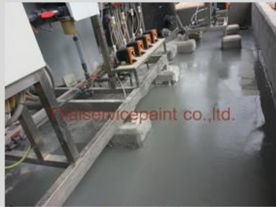
ชื่องาน :งานเคลือบ FRP พื้นที่ใช้งาน :พื้นที่สำหรับวางแท่งเค้เก็บสารเคมี Location :นิคมฯ มาบตาพุด-โรงไฟฟ้า
