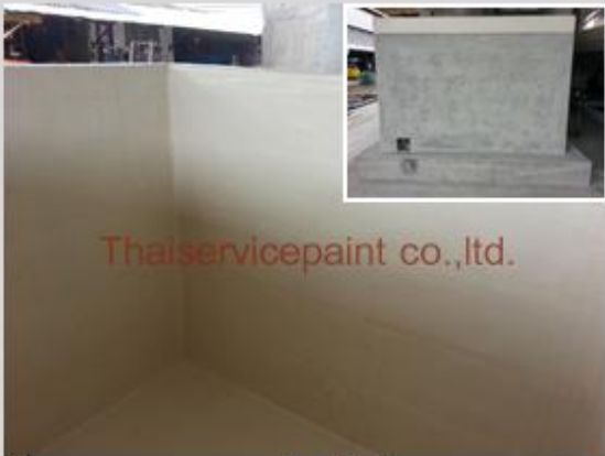
ชื่องาน : งานเคลือบ FRP พื้นที่ใช้งาน : เคลือบแท็งค์เก็บสารเคมี Location : นิคมฯ บางพลี
