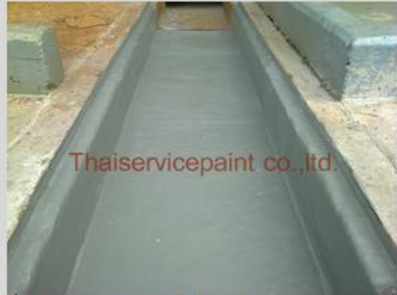
ชื่องาน :งานเคลือบ FRP พื้นที่ใช้งาน :ท่อระบายน้ำ (Gutter) Location :นิคมฯ มาบตาพุด
