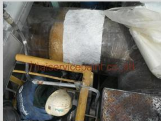
ชื่องาน :งานเคลือบ FRP พื้นที่ใช้งาน :งานซ่อมท่อส่งสารเคมี-ท่อไฟเบอร์ Location :นิคมฯ มาบตาพุด
