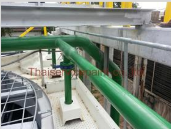
ชื่องาน :งานเคลือบ FRP พื้นที่ใช้งาน :เคลือบท่อส่งสารเคมี Location :นิคมฯ บ้านค่าย - ระยอง
