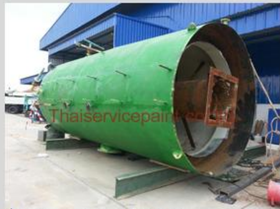
Thaiservicepaint co.,ltd. ชื่องาน :งานเคลือบ FRP พื้นที่ใช้งาน :ท่อระบายอากาศ Location :นิคมฯ อีสเทิร์นซีบอร์ด
