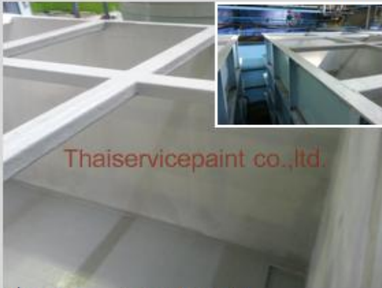
Thaiservicepaint co.,ltd. ชื่องาน :งานเคลือบ FRP พื้นที่ใช้งาน :ถังเก็บสารเคมี Location :นิคมฯ สยามอีสเทิร์น
