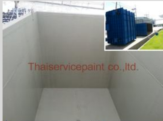
ชื่องาน : งานเคลือบ FRP พื้นที่ใช้งาน : เคลือบภายในแท็งค์เก็บสารเคมี Location : นิคมฯ สยามอีสเทิร์น
