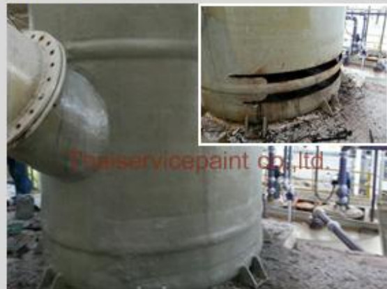
ชื่องาน : งานเคลือบ FRP พื้นที่ใช้งาน : งานซ่อมถังไฟเบอร์ Location : นิคมฯเอเซีย-ระยอง
