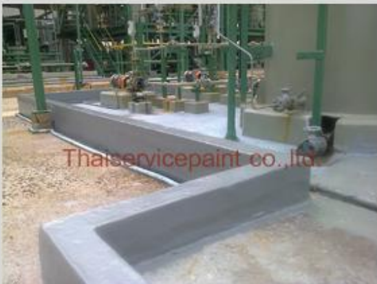
ชื่องาน :งานเคลือบ FRP พื้นที่ใช้งาน :พื้นที่วางแทงค์เก็บสารเคมี Location :นิคมฯ มาบตาพุด
