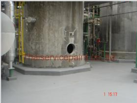
ชื่องาน : งานเคลือบ FRP พื้นที่ใช้งาน : งานเคลือบพื้นFRP-แท็งค์เคมี Location : โรงแยกก๊าซ-ระยอง
