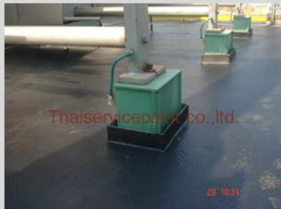
ชื่องาน : งานเคลือบ FRP พื้นที่ใช้งาน : เคลือบพื้นไฟเบอร์กลาส Location : นิคมฯ มาบตาพุด
