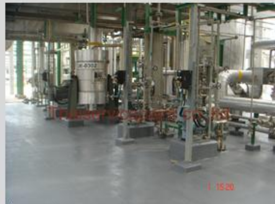
ชื่องาน :งานเคลือบ FRP พื้นที่ใช้งาน :พื้นที่สำหรับวางแทงค์สารเคมี Location :โรงแยกก๊าซ-ระยอง
