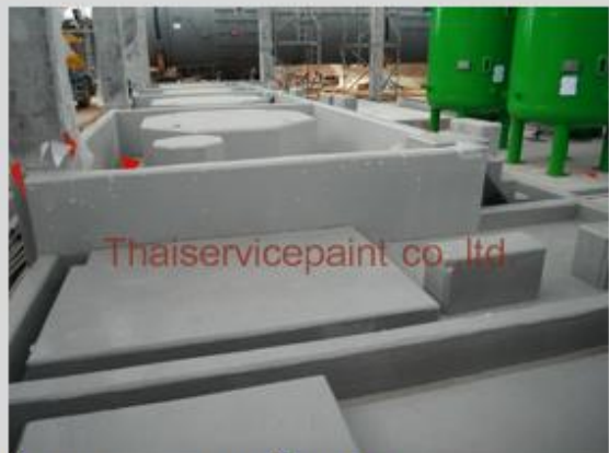
ชื่องาน : งานเคลือบ FRP พื้นที่ใช้งาน : แท่นวางถังเก็บสารเคมี Location : นิคมฯ อีสเทิร์นซีบอร์ด
