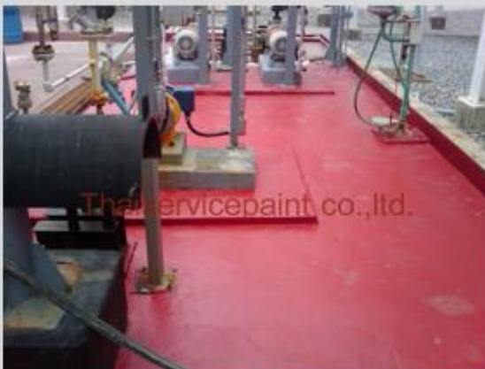
ชื่องาน :งานเคลือบ FRP พื้นที่ใช้งาน :sand coat- ท่อส่งสารเคมี Location :นิคมฯ มาบตาพุด
