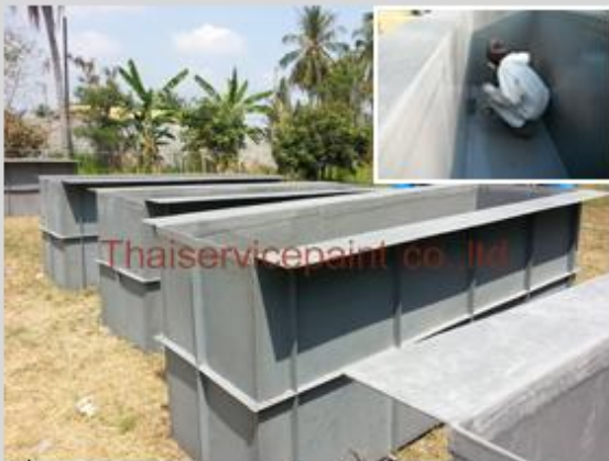
ชื่องาน :งานเคลือบ FRP พื้นที่ใช้งาน :แทงค์เก็บสารเคมี Location :ชลบุรี
