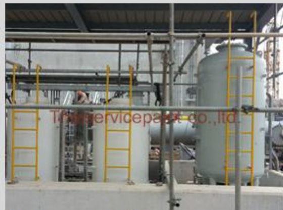
ชื่องาน :งานเคลือบ FRP พื้นที่ใช้งาน :งานเคลือบแทงค์ เก็บสารเคมี Location :นิคมฯ อีสเทิร์นซีบอร์ด-โรงไฟฟ้า
