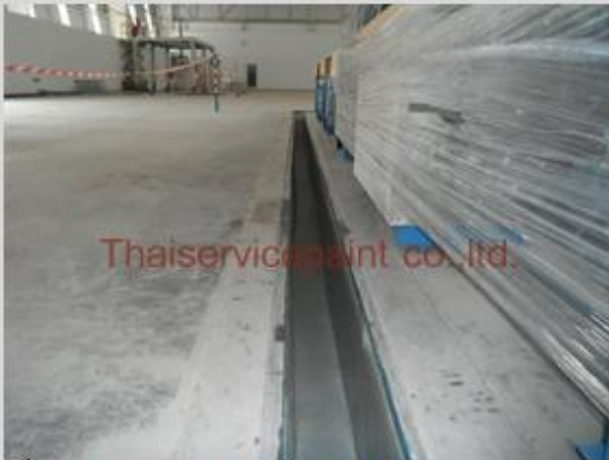
ชื่องาน : งานเคลือบ FRP พื้นที่ใช้งาน : เคลือบรางระบายน้ำภายในโรงงาน Location : นิคมฯ เหมราช-ระยอง
