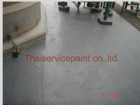
ชื่องาน :งานเคลือบ FRP พื้นที่ใช้งาน :พื้นที่สำหรับวางแทงค์สารเคมี Location :นิคมฯ มาบตาพุด
