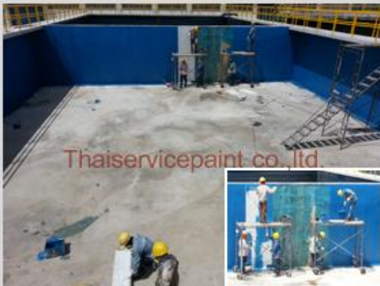
Thaiservicepaint co.,ltd. ชื่องาน :งานเคลือบ FRP พื้นที่ใช้งาน :บ่อบำบัดน้ำเสีย Location :นิคมฯ มาบตาพุด
