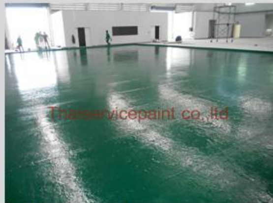
ชื่องาน : งานเคลือบ FRP พื้นที่ใช้งาน : พื้นที่วางเครื่องจักร Location : นิคมฯ อมตะนคร - ชลบุรี
