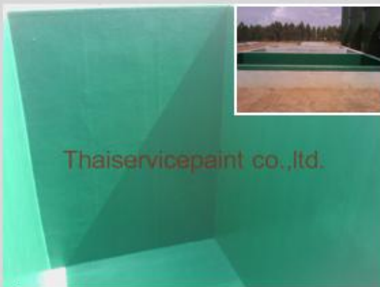
ชื่องาน : งานเคลือบ FRP พื้นที่ใช้งาน : บ่อบำบัดน้ำเสีย Location : ชลบุรี
