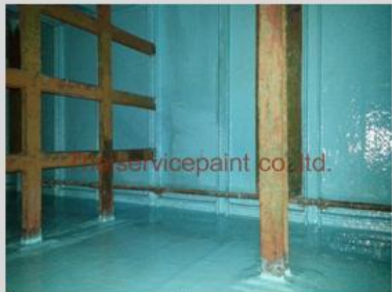
ชื่องาน : งานเคลือบ FRP พื้นที่ใช้งาน : แทงค์เก็บสารเคมี Location : บางปะกง
