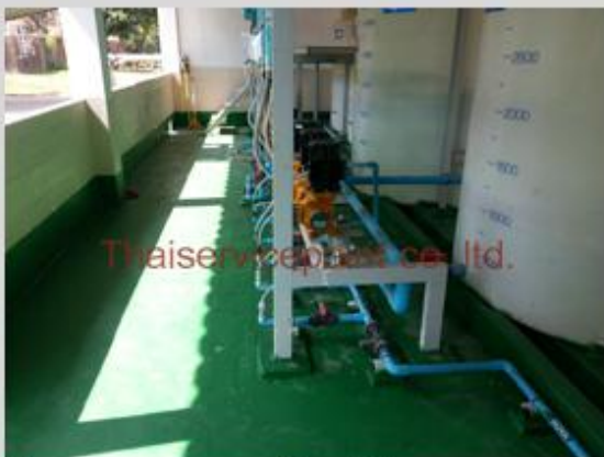
ชื่องาน :งานเคลือบ FRP พื้นที่ใช้งาน :พื้นที่บริเวณเก็บสารเคมี Location :สยามอีสเทิร์น อินดัสเตรียลพาร์ค
