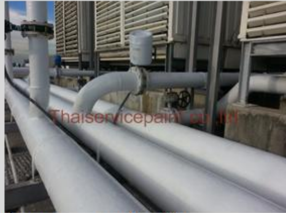
ชื่องาน : งานเคลือบ FRP พื้นที่ใช้งาน : งานเคลือบ Pipe Cooling Location : สยามพารากอน
