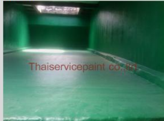
ชื่องาน :งานเคลือบ FRP พื้นที่ใช้งาน :บ่อบำบัดน้ำเสีย Location :นิคมฯ เหมราช-ระยอง
