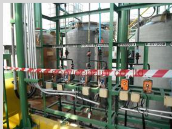
ชื่องาน :งานเคลือบ FRP พื้นที่ใช้งาน :พื้นที่บริเวณเก็บสารเคมี Location :นิคมฯ มาบตาพุด
