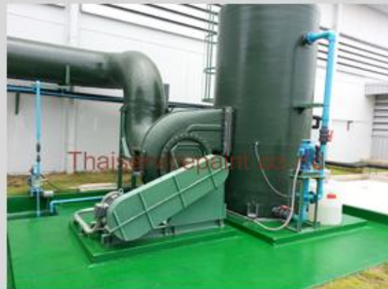
ชื่องาน : งานเคลือบ FRP พื้นที่ใช้งาน : พื้นที่วางเครื่องจักร Location : นิคมฯ อมตะนคร - ชลบุรี
