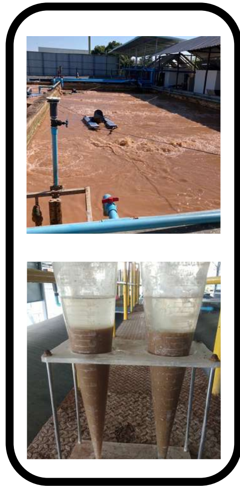
ตะกอนในระบบ บำบัดน้ำเสีย
