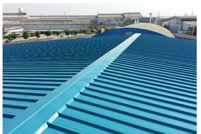
Double Roof โรงงานนิปปอน อมตะนคร
